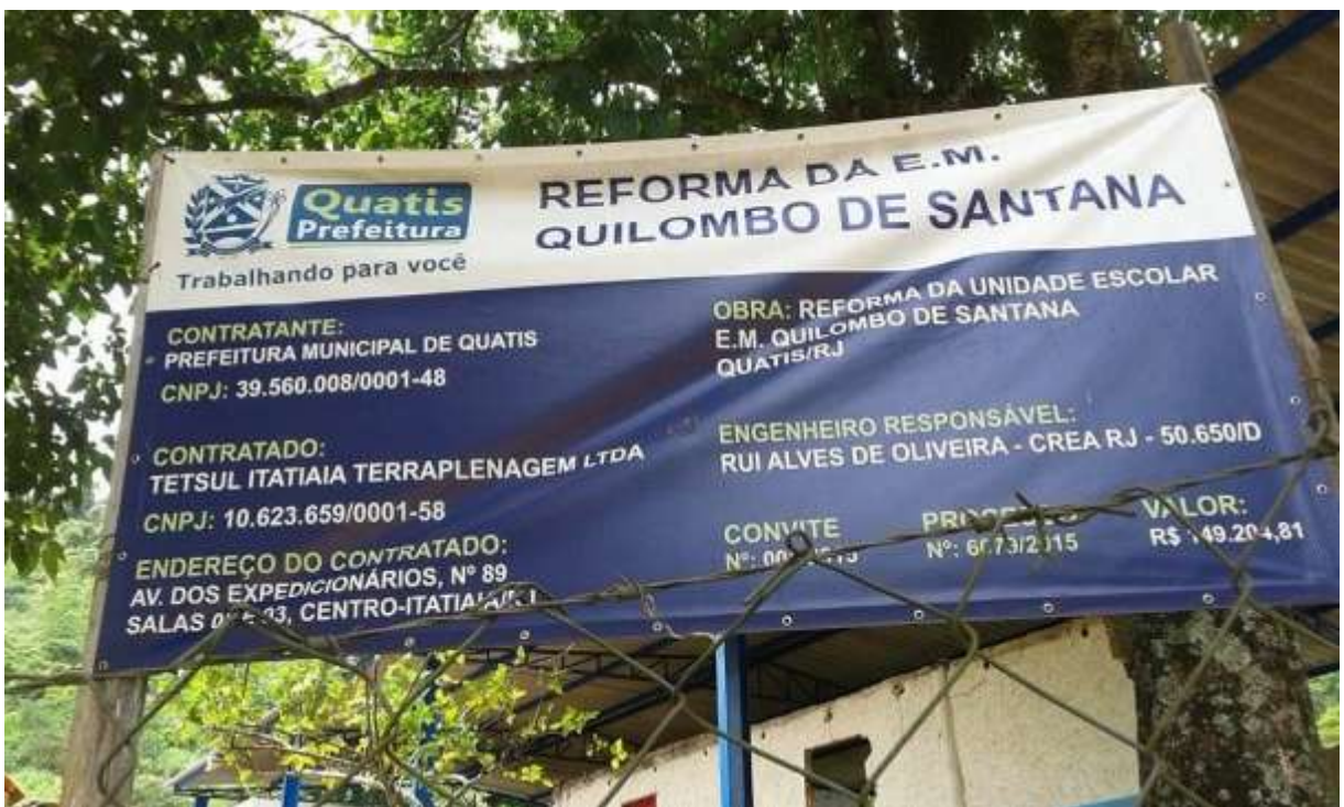
Imagem III: Placa da Prefeitura de Quatis indicando a obra na Escola
