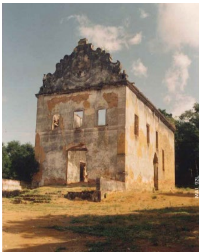
Figura 21 - Igreja S. José do Queimado – Vista parcial da fachada frontal e lateral (1992)
