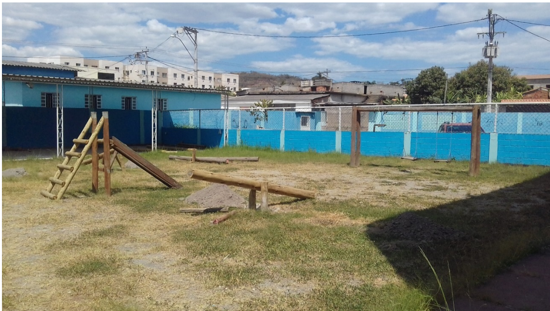
Imagem 11 – Parquinho da escola em manutenção (ago. 2017)
