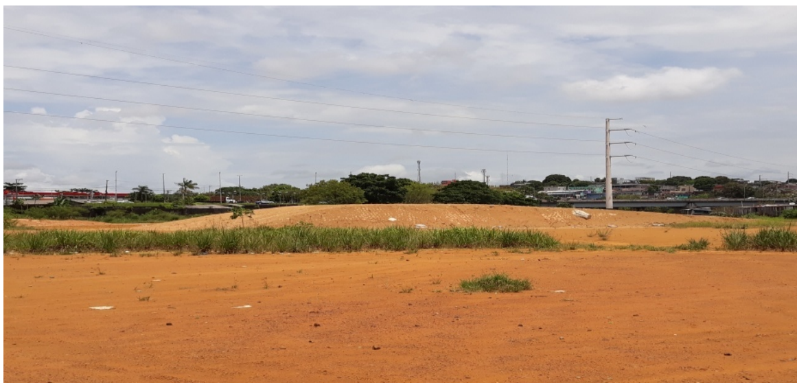
Figura 6 - Aterro da margem do igarapé da Cachoeira Grande
