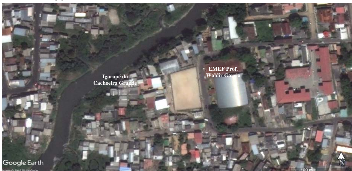
Figura 1 - As imediações da escola em novembro de 2011, pouco antes das intervenções do PROSAMIM
