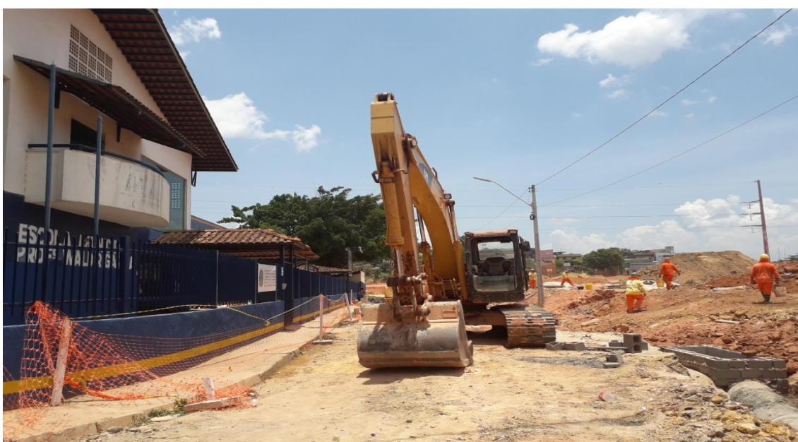
Figura 15 - Canteiro de obras do aterro do igarapé da Cachoeira Grande – set/2018
