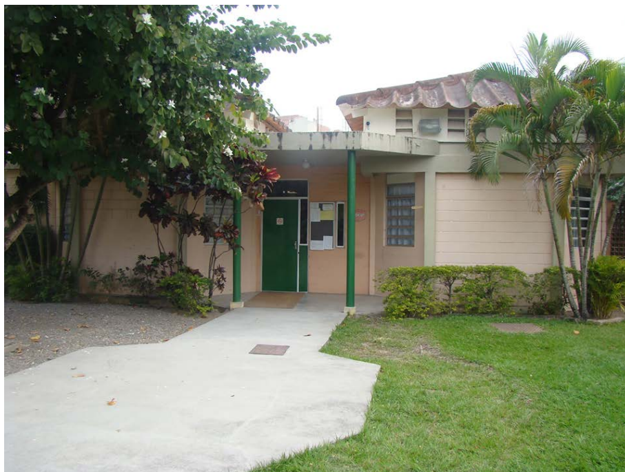
Figura 5 - Entrada da Creche UFF. Pátio das pedrinhas
