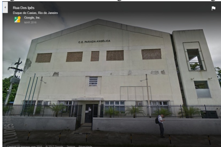
Figura 20 – Fachada do Colégio Estadual Parada Angélica
