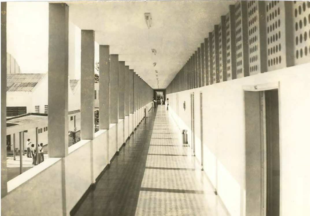
Fotografia 19 - Corredor do bloco de sala de aulas da ETFMT (1979)
