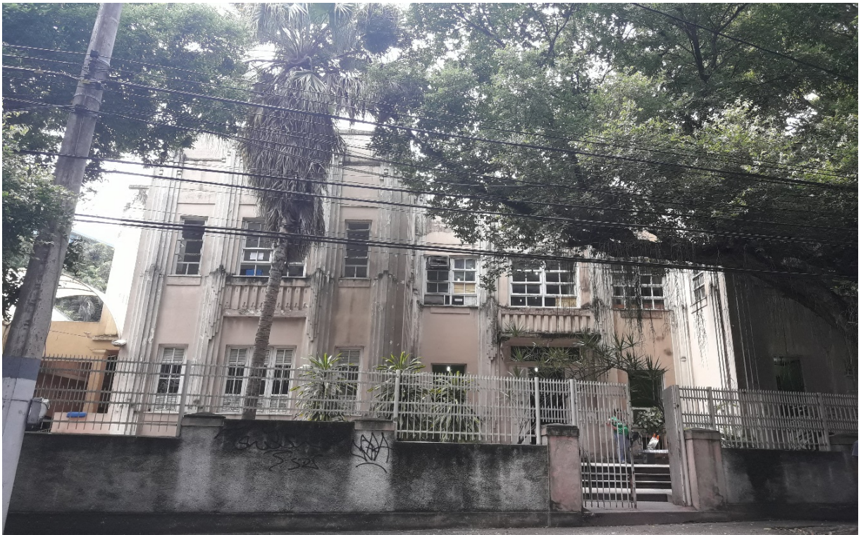
Figura 1 – Fachada atual da Policlínica Almir Madeira – antigo Instituto de Proteção e Assistência à Infância de Niterói
