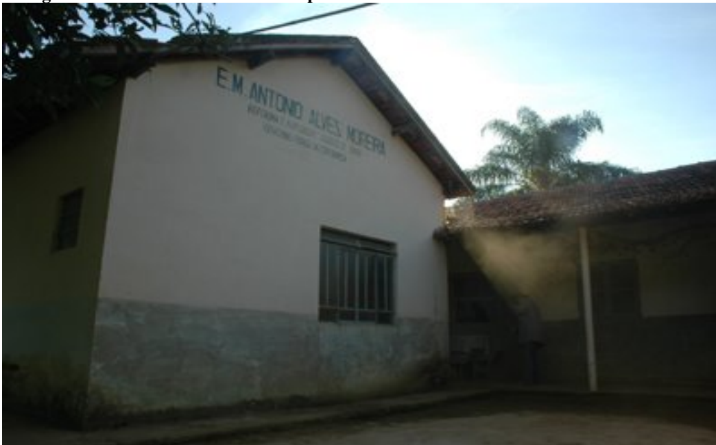
Imagem 02 – Prédio da Escola Municipal Antônio Alves Moreira.
