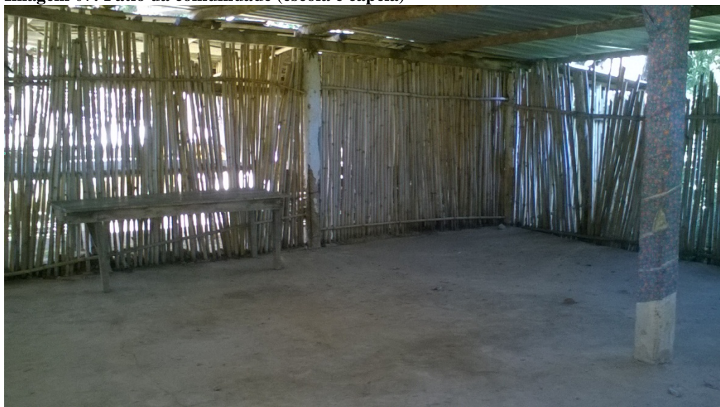
Imagem 07: Pátio da comunidade (escola e capela)
