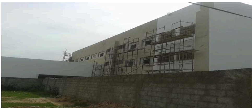
Figura 7 - Escola em fase de obras - 2
