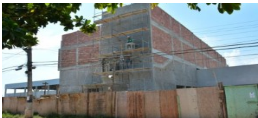
Figura 6 - Escola em fase de obras - 1
