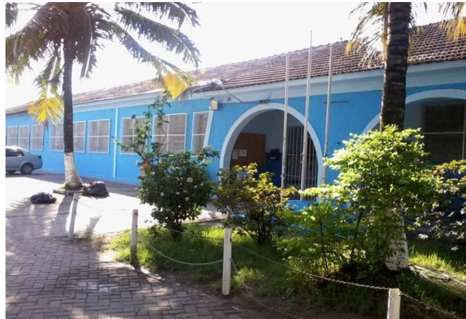
Figura 2- Fachada do Colégio Municipal Amaral Peixoto
