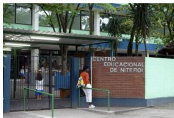
Fotografia 23 – Fachada do Centrinho
