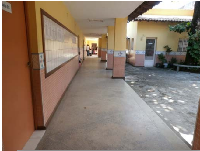
Fotografia 7 - Corredor que leva às salas, ao lavatório e ao play
