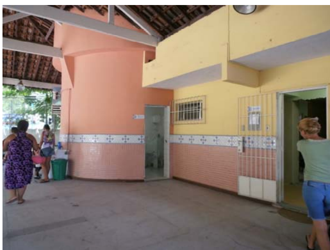
Fotografia 8 - Pátio coberto com bebedouros e banheiros infantis
