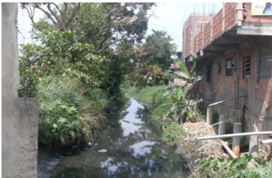
Proximidade das casas à aflente do Rio Sarapuí na Vila São José, região do Pantanal, Duque de Caxias. Foto 2: Catrin Borgatti Gouveia (2010) Fonte: TENREIRO, 2012, p. 42.
