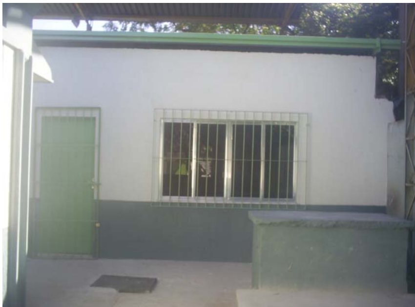
Fotografia 6 - A parte externa da nova sala, onde futuramente será o laboratório de informática da escola
